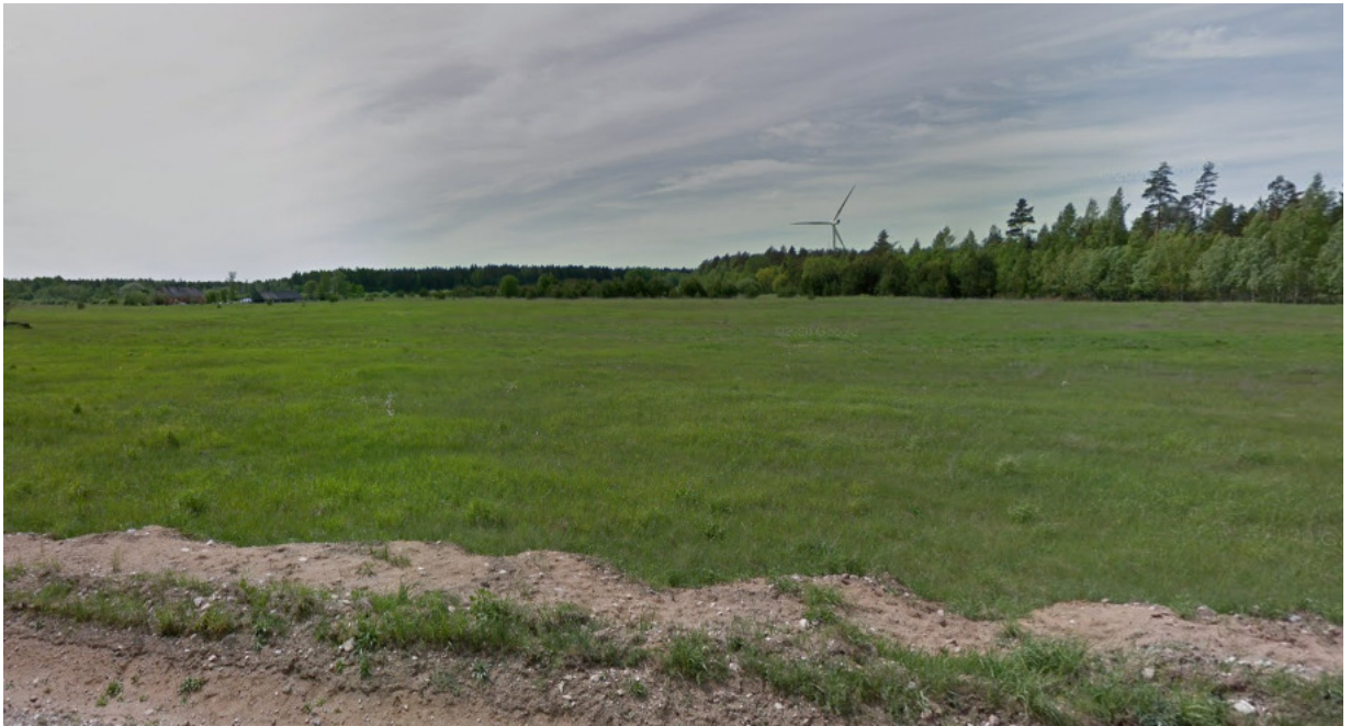
11.attēls. Skats uz Vēdes elektrostaciju no valsts vietējā autoceļa V1312. Foto: https://www.google.com/maps
